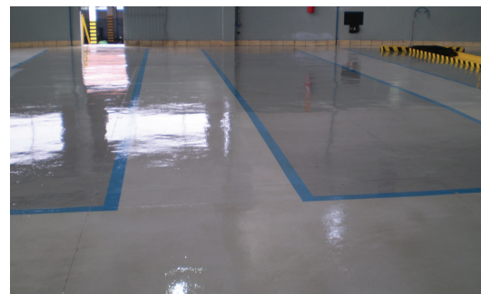
Depois da impermeabilização
