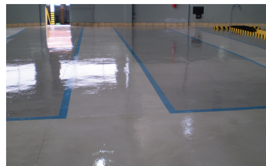
Depois da impermeabilização
